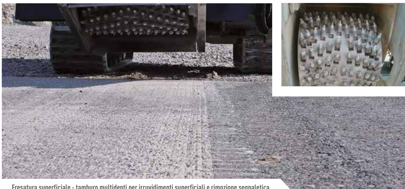
Fresatura superficiale - tamburo multidententi per irruvidimenti superficiali e rimozione segnaletica
